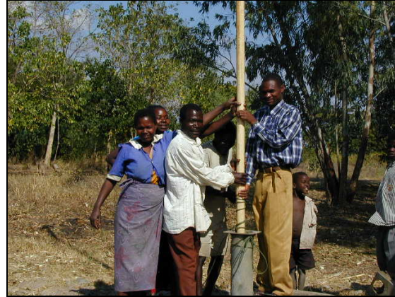
Villageois réparant les tuyaux de remontée d'eau.
