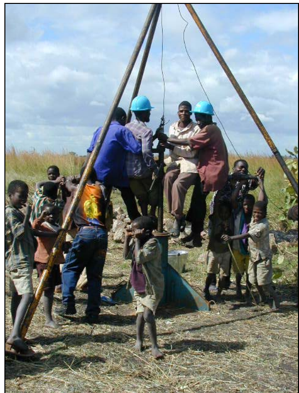
Creusement d'un forage au « vonder rig ». Les villageois assurent la « poussée verticale »...
