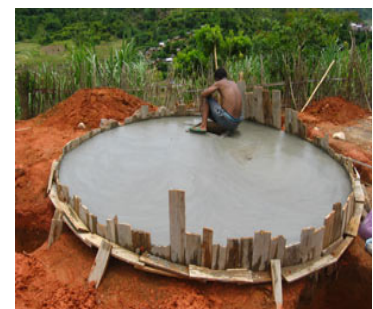
Finition dalle de couverture de la citerne
