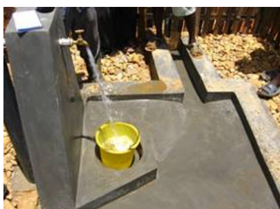
Mise en place d'une borne fontaine
