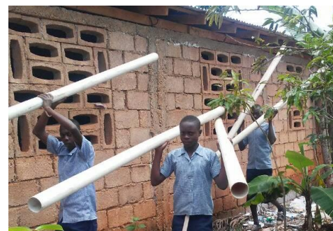
Réhabilitation à l'école de Bernagousse
