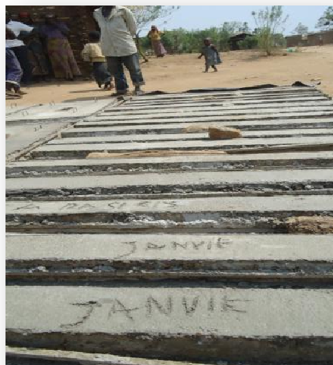
Deux poutres pour maintenir la dalle de la latrine sont attribuées à chaque ménage.
