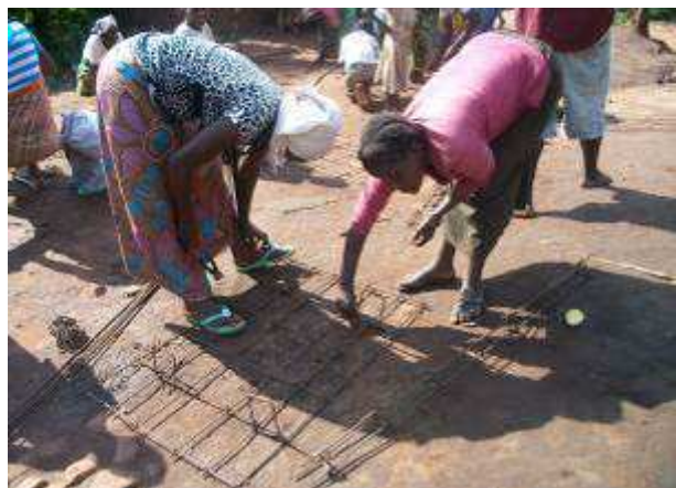
Femmes préparant le ferrailage de la dalle
