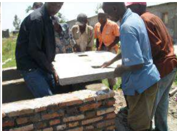
Installation de la dalle sur les fosses
