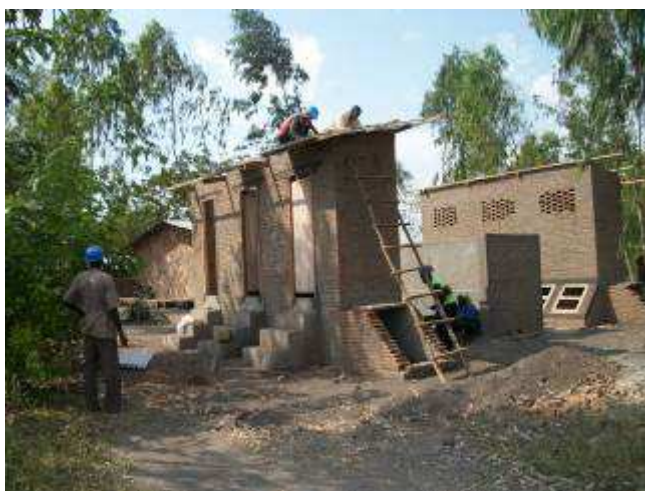
Construction du bloc de latrines ecosan à l'école primaire de Maramvya 1
