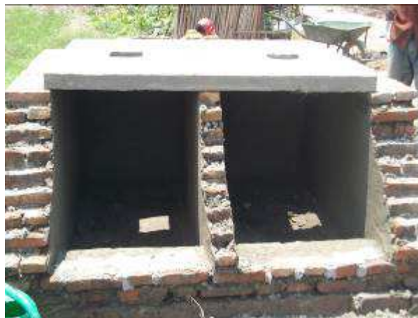
Latrine ecosan ménage en construction
